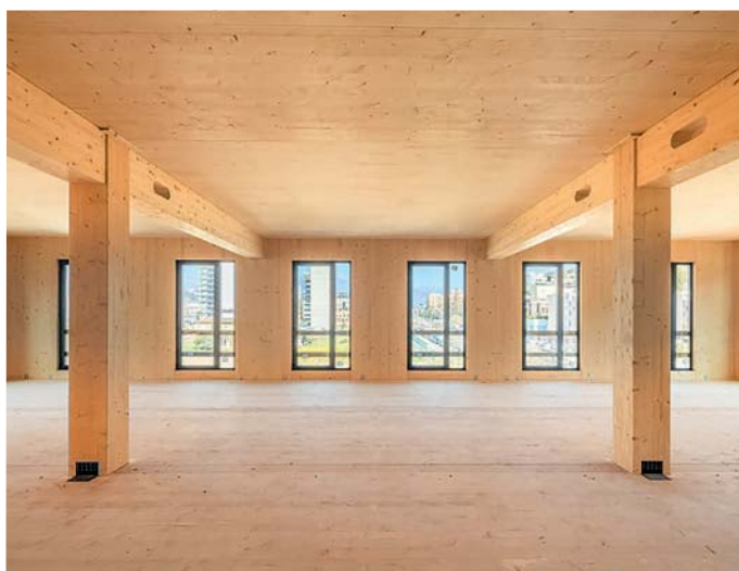
Plancher en panneaux « CLT »
